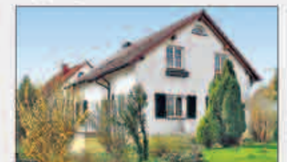
Landhaus, Wohnfl. ca. 160 m², Nutzfl. ca. 70 m², Gndst. ca. 478 m², € 230.000,-, ID-Nr. 1221526 Jena (D) • +49-(0)3641-23 26 40
